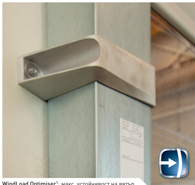
WindLoad Optimiser 1 : макс. устойчивост на вятър
